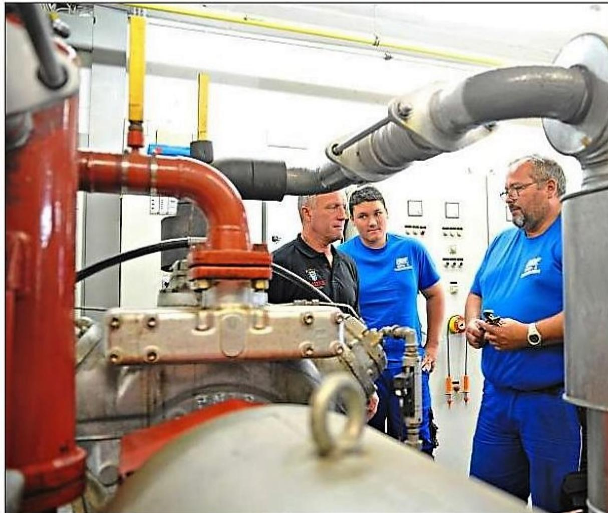
**Die alte Kälteanlage**, die wartungsaufwendig ist und mit dem giftigen Ammoniak betrieben wird, hätte ausgedient, wenn die Eishallensanierung angepackt wird. Die Entscheidung, wie die Sanierung aussehen soll, hat der Stadtrat noch nicht getroffen. – Foto: Lukaschik
